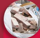
gravats, déchets de démolition
