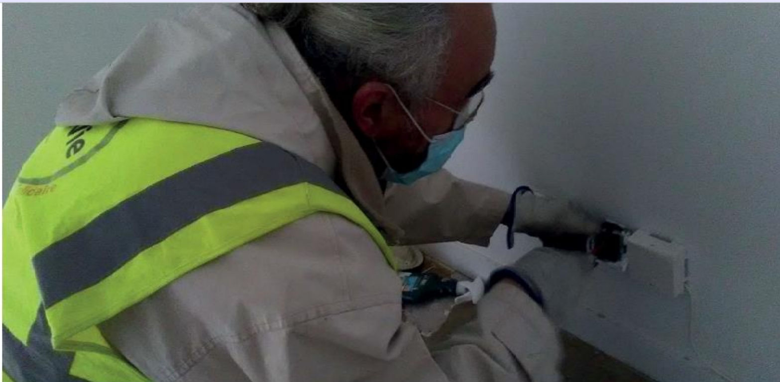
François-Xavier, le doyen de RéaVie, à l'oeuvre sur la dépose d'une prise électrique.
